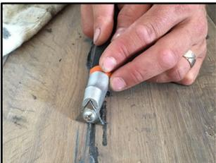
Überstehenden Hartwachs mit entsprechendem Werkzeug entfernen.
