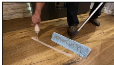
Zuerst Mopp mit Hartwachsöl «to go» benetzen und Öl anschliessend auf den Boden sprühen.
