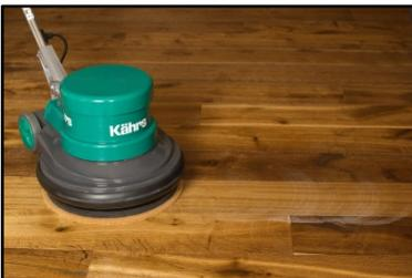
Das Satinöl wird sofort mit der Einscheibenmaschine und aufgesetztem weissen oder beige Pad eingearbeitet. Es dürfen keine Öl-Spritzer zurückbleiben.
