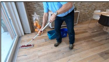
Wischmopp im Kübel mit Wasser auswaschen und Reinigung mit frischem im Öl-Refresher eingetauchten Mopp weiterführen. Der entstandene Wasserfilm sollte in ca. 5-10 Minuten wieder trocken sein.
