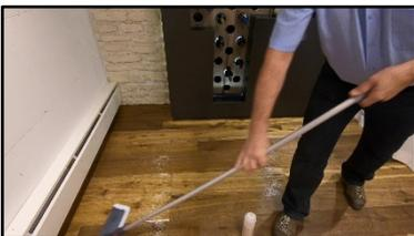
Hartwachsöl «to go» mit Wischmopp gleichmässig längs der Dielen verteilen.
