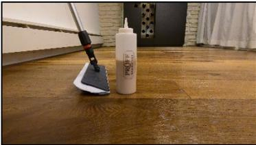
Hartwachsöl «to go» zuerst gut schütteln und anschliessend in eine Plastikflasche mit kleiner Öffnung abfüllen.
