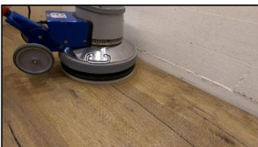
Kährs-Profiöl mit der Einscheibenmaschine und aufgesetztem weissen oder beigem Pad in Dielenrichtung einarbeiten.
