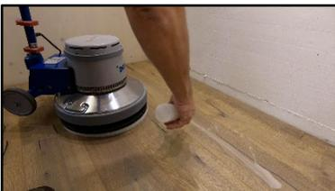
Kährs Profiöl mit einer Plastikflasche auf den Boden sprühen. (1 Liter Profiöl reichen etwas für 60-80 m<sup>2</sup>)
